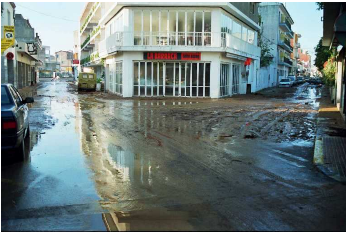
Acumulacions de fang a la cruïlla entre els carrers Església i Víctor Concas.
