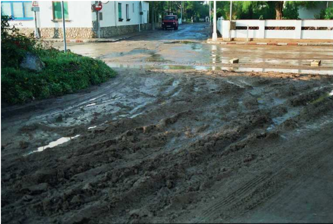
Estat en que va quedar la zona de la parada d'autobús.
