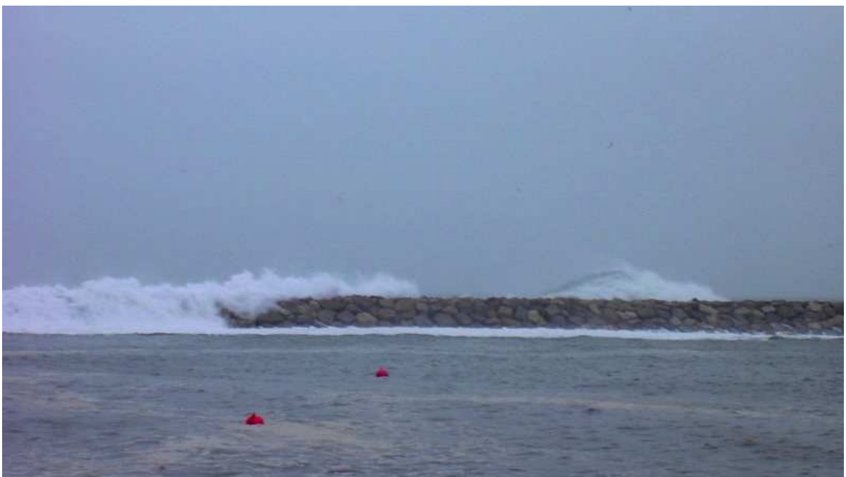
Des de terra, el dia 21, es podien veure els cops de mar travessar l'espigó de llevant i com trencaven fora l'espigó, fins i tot a una certa distància en fora.
