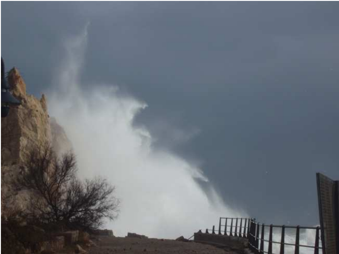
Els esquitxos dels cops de mar superaven, fins i tot, l'alçada de la Bleda, que té més de 30 metres d'altura. Es pot veure com ja s'havia trencat part del mur del Passeig.
